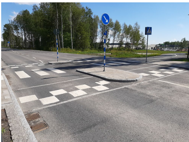
Figur 20 Exempel på platågupp
