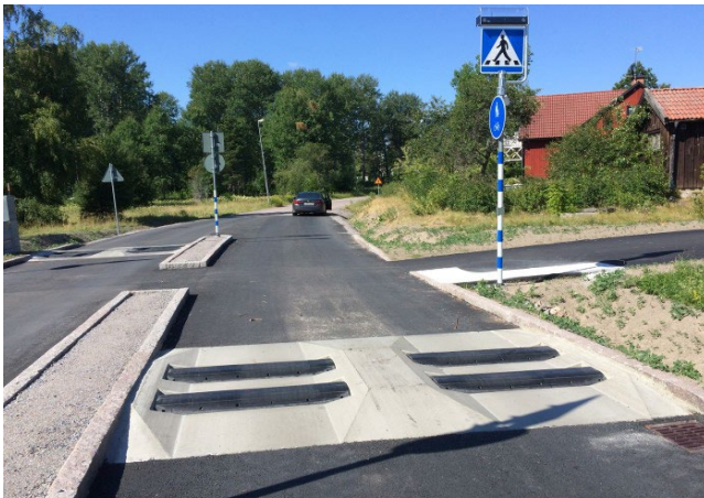
Figur 18 Exempel på passivt dynamiskt gupp, IFD (Intelligent Fart Dämpare), med plogbladsavvisande delar.
