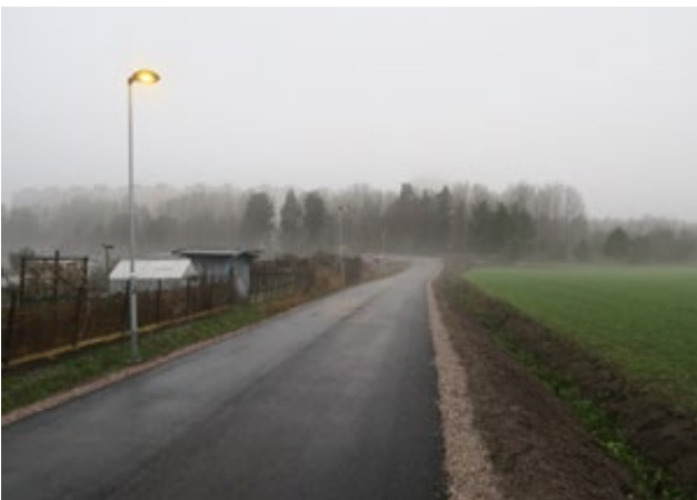
Friliggande GC-väg norr om Hägernäs station
