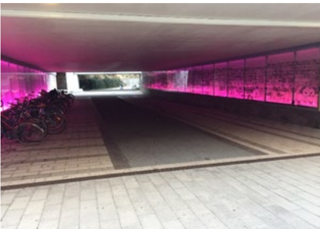
Tunnel under Roslagsbanan
