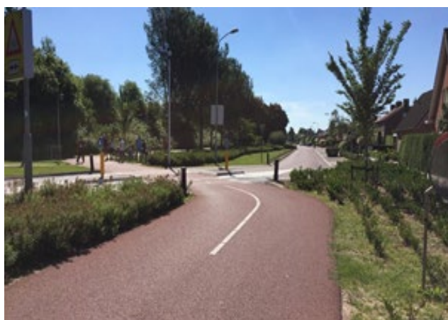
Exempel på utformning av diagonal cykelpassage
