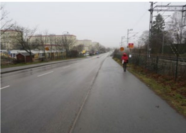
Kombinerad GC-bana på Södervägen
