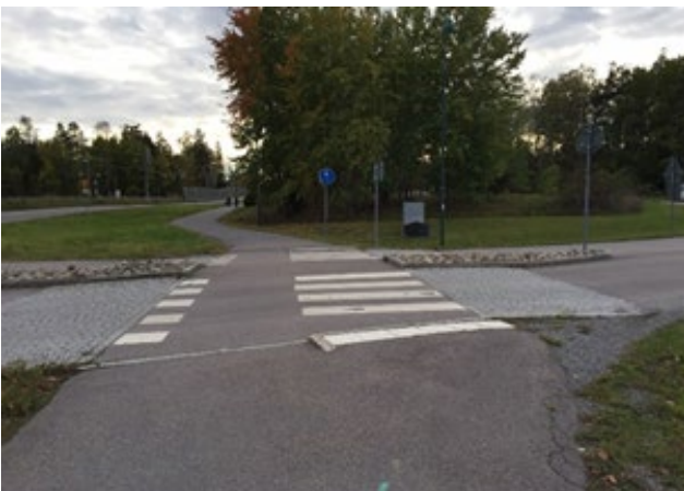
Passage över lokalgata utmed Svinningevägen
