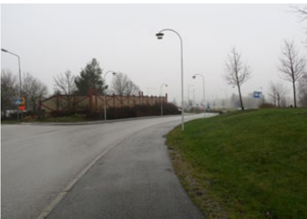
Anslutning mellan Bergtorpsvägen och Södervägen
